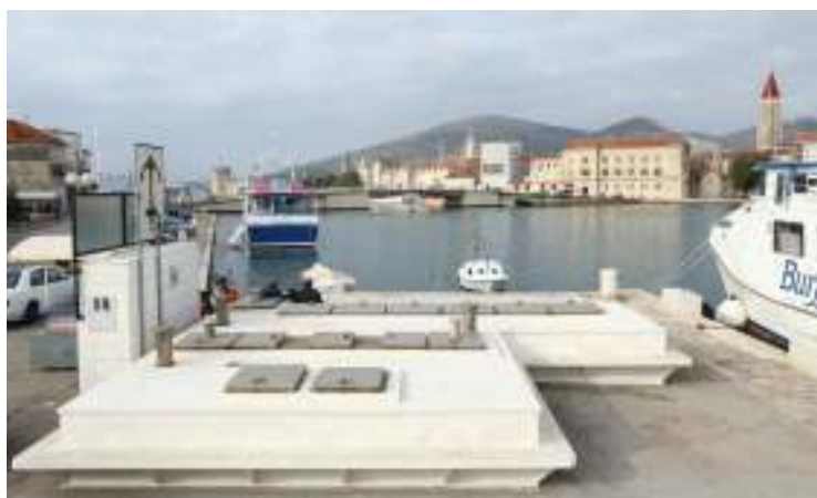
Crpna stanica - Čiovo
