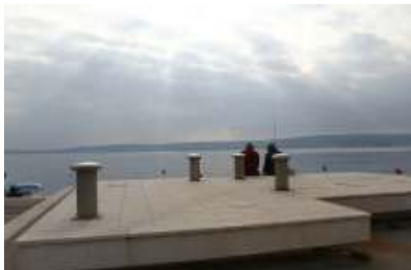
Crpna stanica - Kaštel Novi
