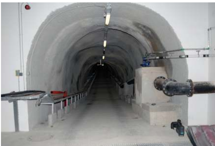
Hidrotehnički tunel Čiovo – pogled iz sjeverne portalne građevine
