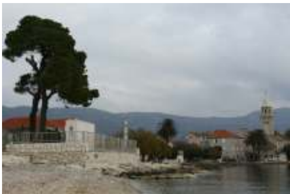
Crpna stanica - Nehaj
