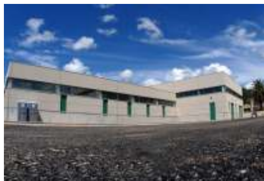
Uređaj za pročišćavanje otpadnih voda Divulje – zgrada rešetki i zgrada aeriranog pjeskolova i mastolova
