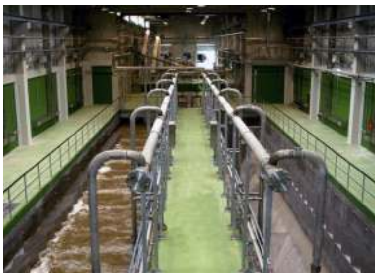
Uređaj za pročišćavanje otpadnih voda Stupe – dio postrojenja: dvokomorni aerirani pjeskolov i mastolov
