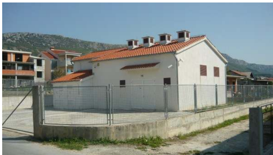
Crpna stanica Kaštel Lukšić
