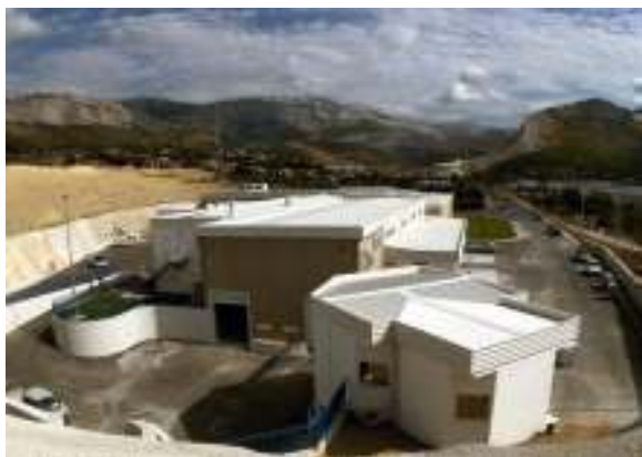
Uređaj za pročišćavanje otpadnih voda Stupe – zgrada postrojenja
