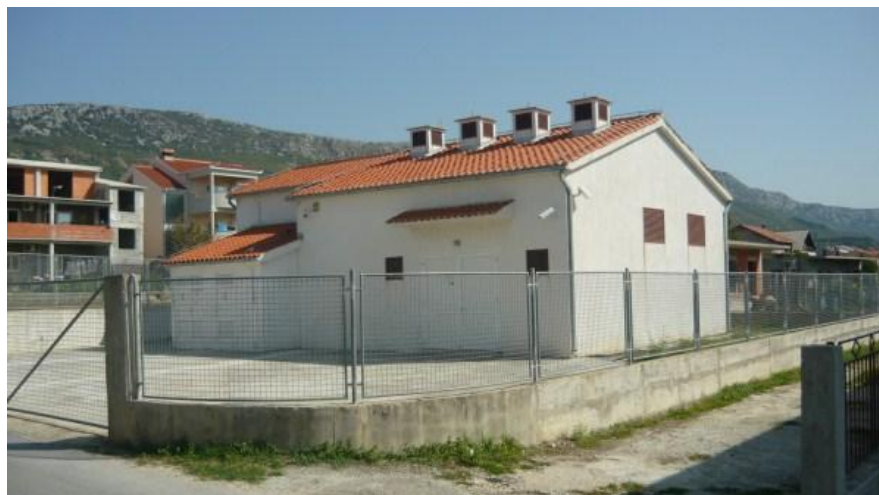
Crpna stanica Lukšić
