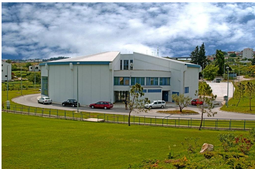
Crpna stanica Ravne Njive
