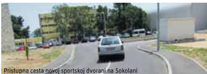
Pristupna cesta novoj sportskoj dvorani na Sokolani
